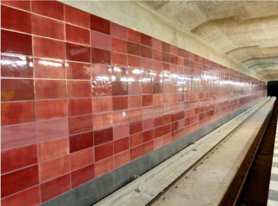
U-Bahnhof Yorckstraße | Berlin , Neugestaltung Gleishinterwand
