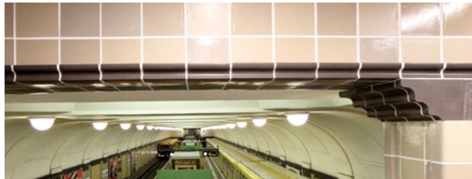
U-Bahnhof Platz der Lufbrücke Berlin, Neugestaltung Gleisvorhalle
